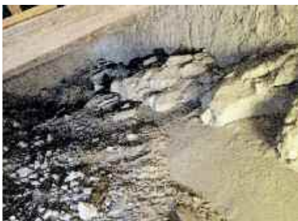
Fig. 23 - Sant'Agata de' Goti, chiesa di S. Menna. Intercapedine tra l'estradosso dell'abside e le coperture a falda. Si notano la calotta absidale consolidata e i conci costituenti l'estradosso dell'arco dell'abside (foto R. Longo).
