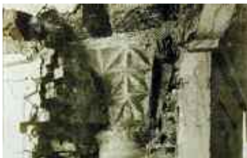
Fig. 6 - Sant'Agata de' Goti, chiesa di S. Menna. Il rinvenimento delle colonne dentro i pilastri nel 1921 (foto F. Iannotta).
