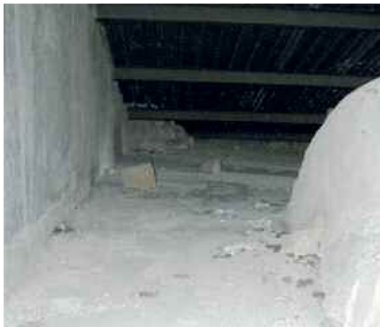
Fig. 16 - Sant'Agata de' Goti, chiesa di S. Menna. Intercapedine tra estradossi e coperture del portico antistante la chiesa. Sulla sinistra il muro di facciata, sulla destra si vede parte dell'estradosso della lunetta del portale (foto R. Longo).
