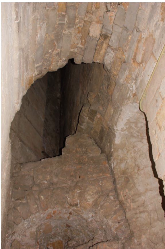
Fig. 11. Palermo, Palazzo Reale, chiesa inferiore, deambulatore di Nord-Est. Si osserva la sporgenza delle absidi della Cappella Palatina rispetto al filo del muro di fondo della Chiesa inferiore (foto: Ruggero Longo)
