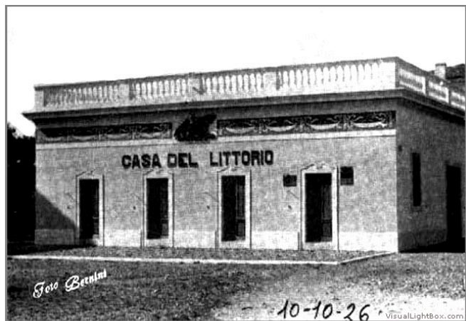
1926 - La Casa del Littorio costruita dalla maggior parte dei vadesi lavorando sabato e domenica gratis.
