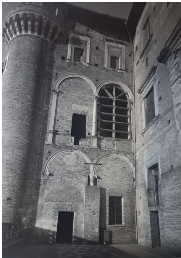
99 Opening the loggia overlooking the Cortile del Gallo, work in progress. 1938-1955 (Unknown author, Fondo Rotondi, 1, Archivio Soprintendenza Galleria Nazionale delle Marche, Urbino)
