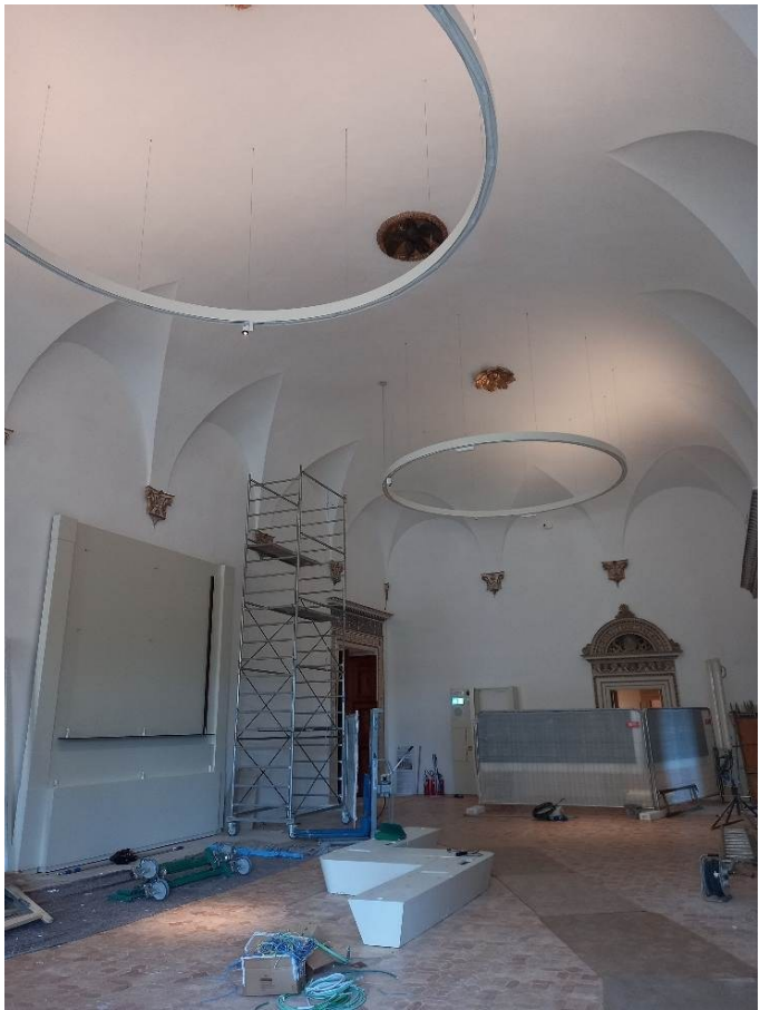
142 Sala degli Angeli work in progress, 2025 (A. Fapanni)
