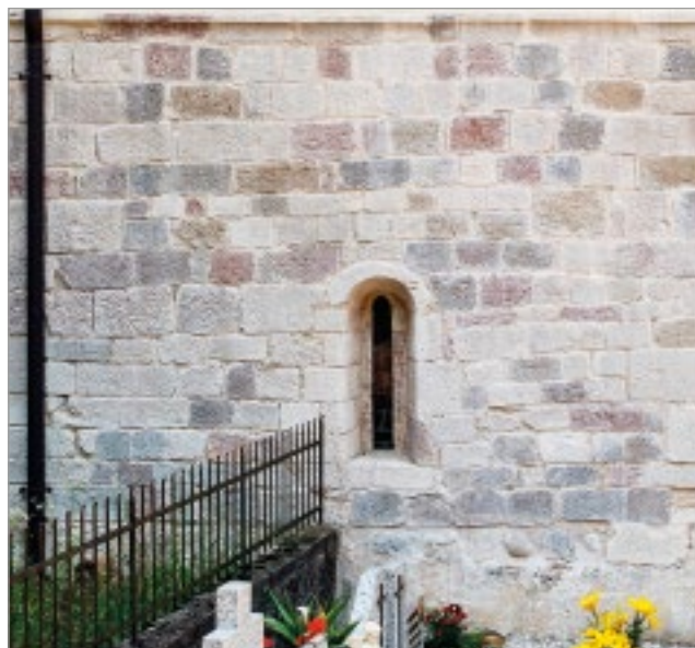
fig. 7 – Paramento esterno della parete nord est del battistero. La tecnica costruttiva è più irregolare rispetto ai lati frontali e all'interno dell'edificio; i filari sono ondulati e si nota una maggiore concentrazione di blocchetti di piccole dimensioni soprattutto ai lati della finestra (foto ed elaborazione di Martina Andreoli e Paolo Chistè, Università di Trento).
