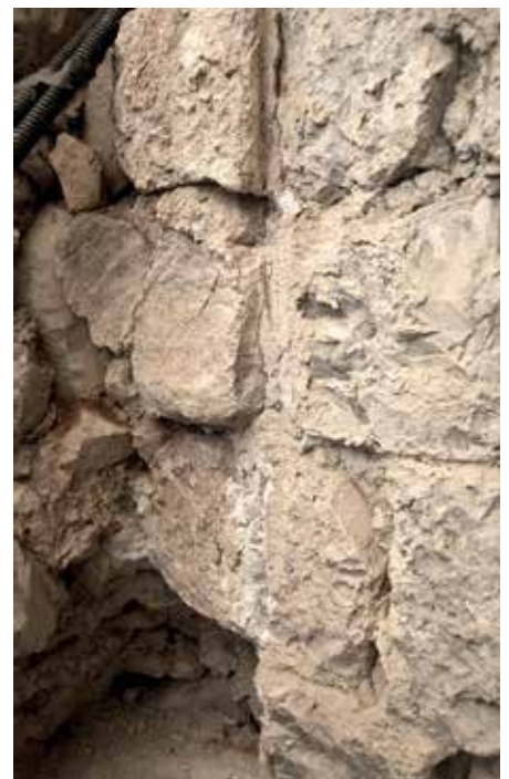
Fig. 11. Sottotetto: giunto d'angolo (particolare).
