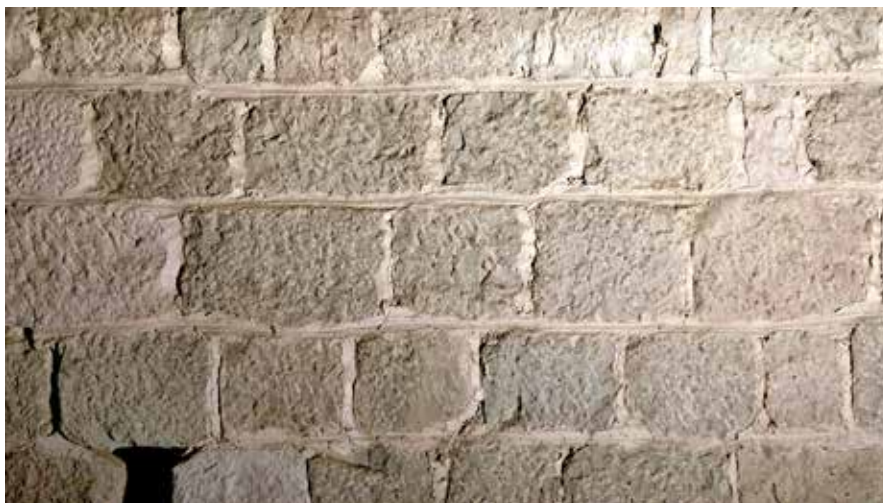
Fig. 7. Sottotetto: divisorio meridionale (particolare). Lavorazione delle superfici e finitura dei giunti con stilatura a scivolo.
