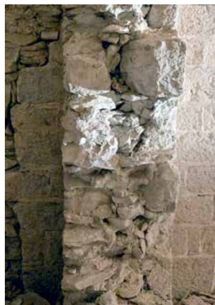
Fig. 8. Sottotetto, muro di testata (navata orientale): sezione.
